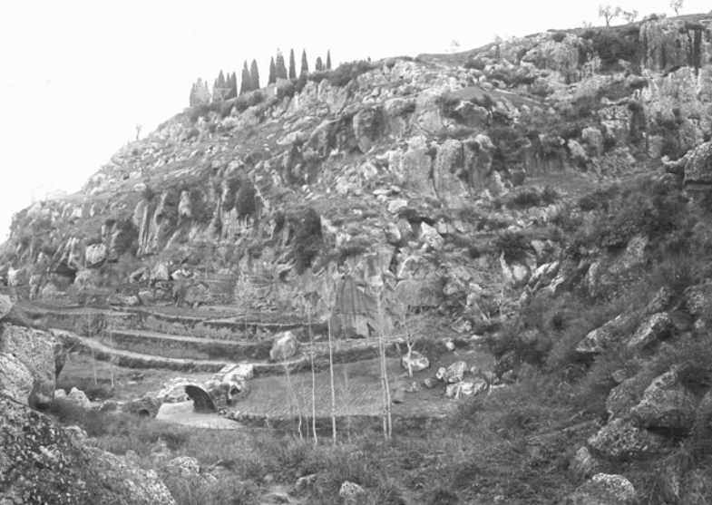
4 Panorama della vallata sotto il cimitero senza il ponte.
