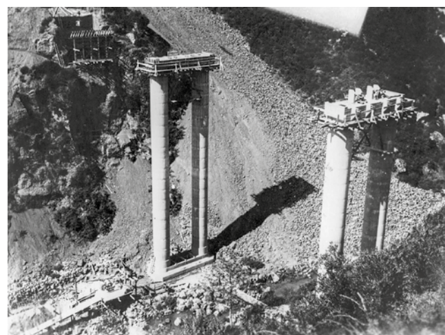
6 Le colonne di cemento armato destinate a sorreggere la centina. Foto Archivio Biblioteca Comunale
