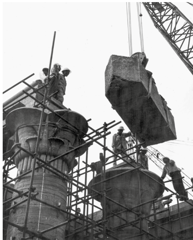
3 Smontaggio di un architrave in arenaria. Foto G. Sabbini
