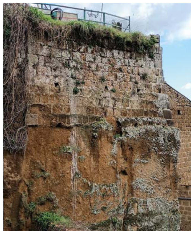
13 Blera, Montarone. Parte basamentale della torre in prossimità di Porta Marina
