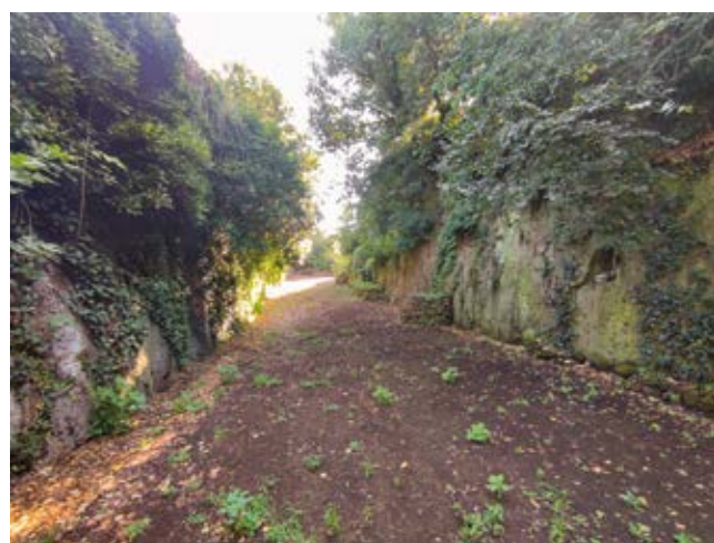
7 Blera, Cavone. Fossato difensivo visto da Ovest
