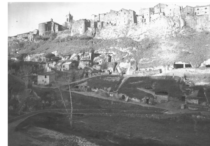
3 Il ponte medievale e la Torretta prima della costruzione del frantoio. Foto Archivio Biblioteca Comunale
