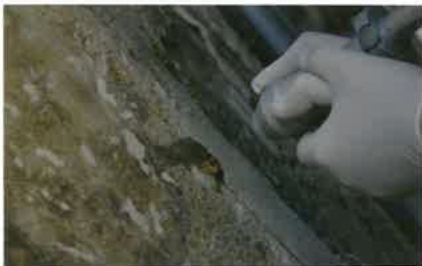
Fig. 11 - Intervento di pulitura con strumentazione laser.
