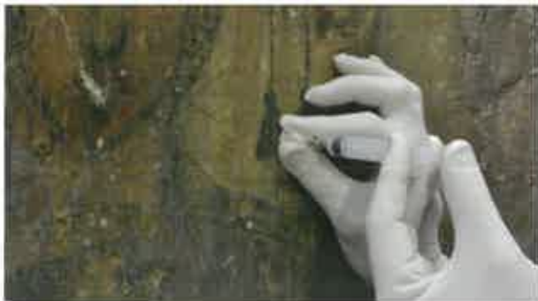
Fig. 9 - Rifacimento dei difetti di adesione dell'intonaco.
