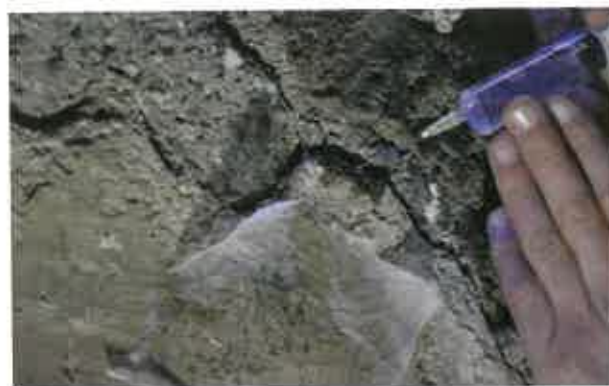
Fig. 8 - Rifacimento dei difetti di coesione dell'intonaco.
