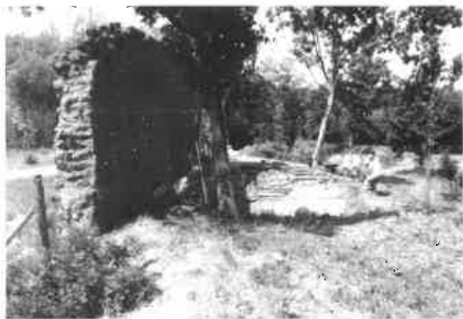
Panoramica della zona oggetto dell'intervento.
