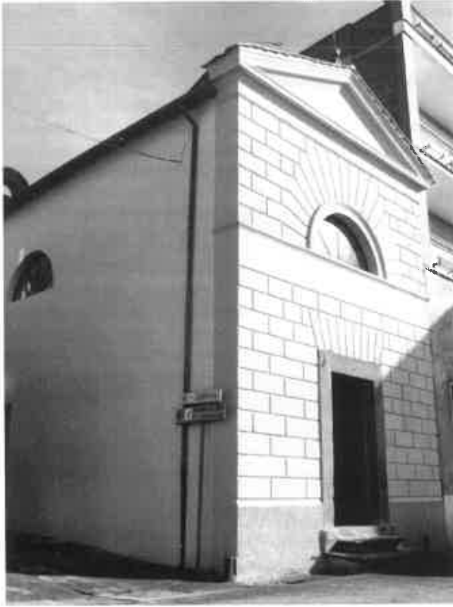
Facciata della chiesa del Suffragio dopo il recente restauro.
