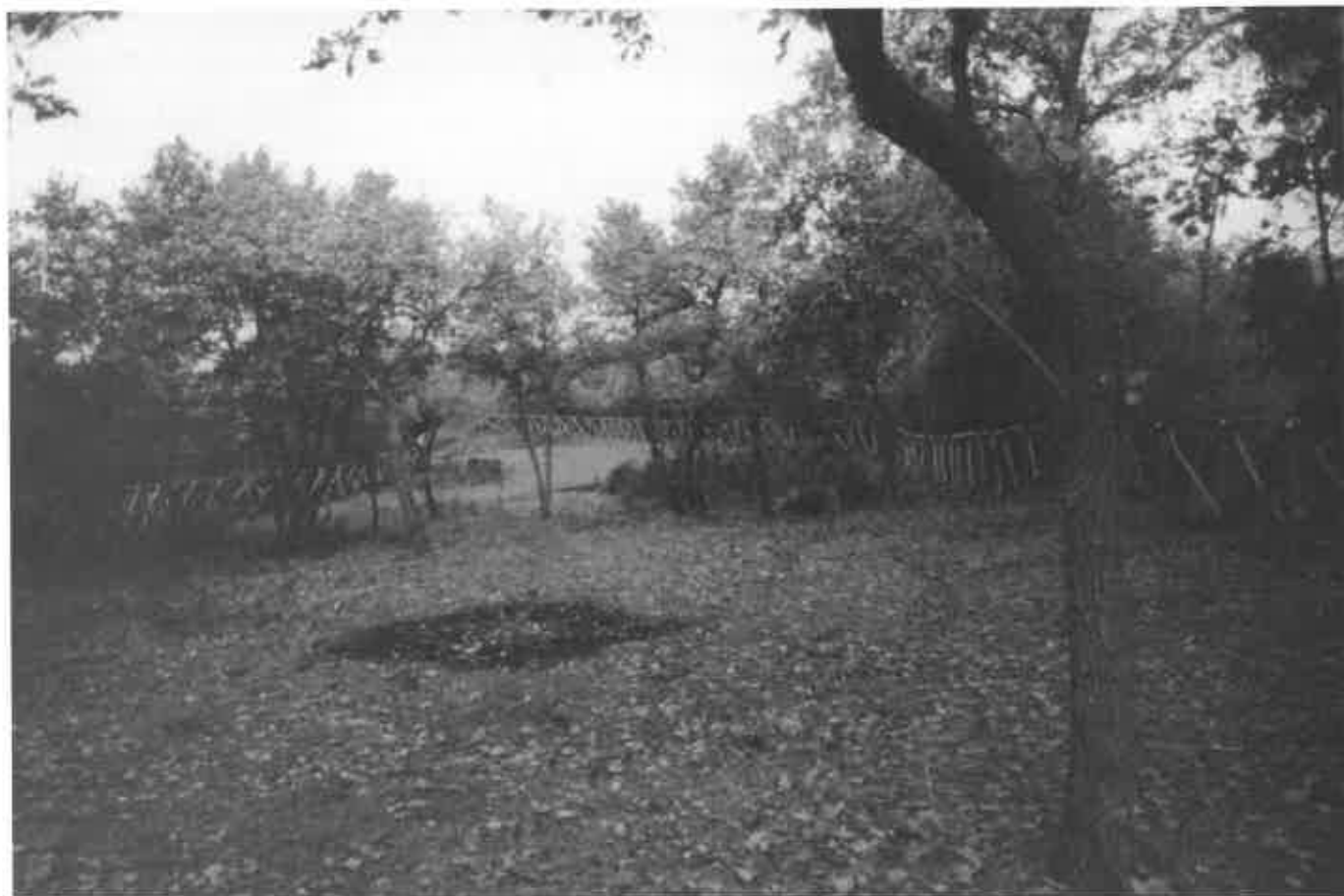
Lavori di sistemazione della passeggiata archeologica di Petrolo.
