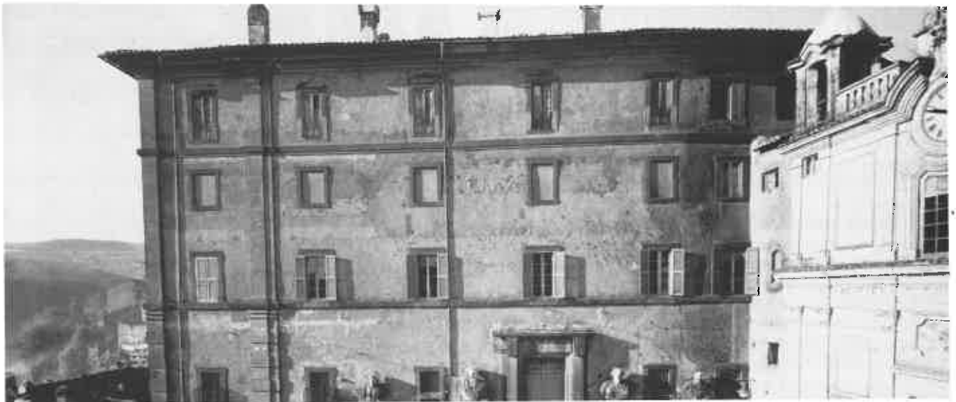
Facciata principale del palazzo di Bassano Romano (Busti in marmo - Portale Ultimo piano dell'edificio aggiunti nel XVII secolo da Vincenzo Giustiniani
